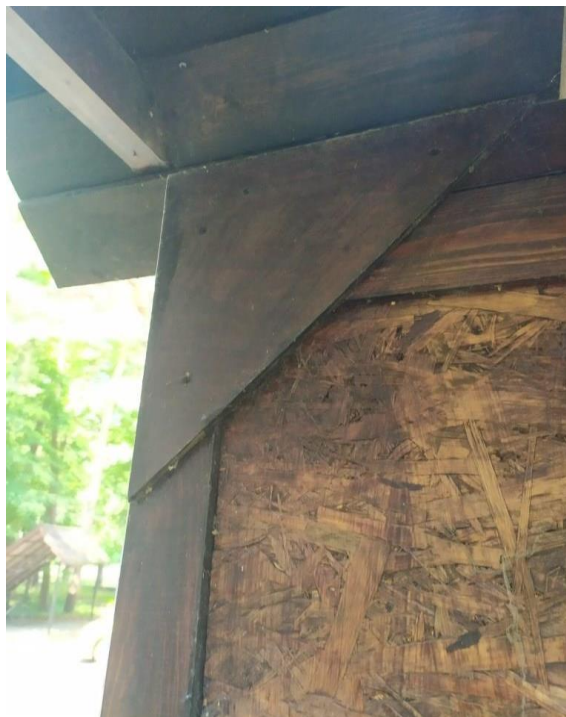
Płyta OSB włożona w ramę, zabezpieczona narożnikami
