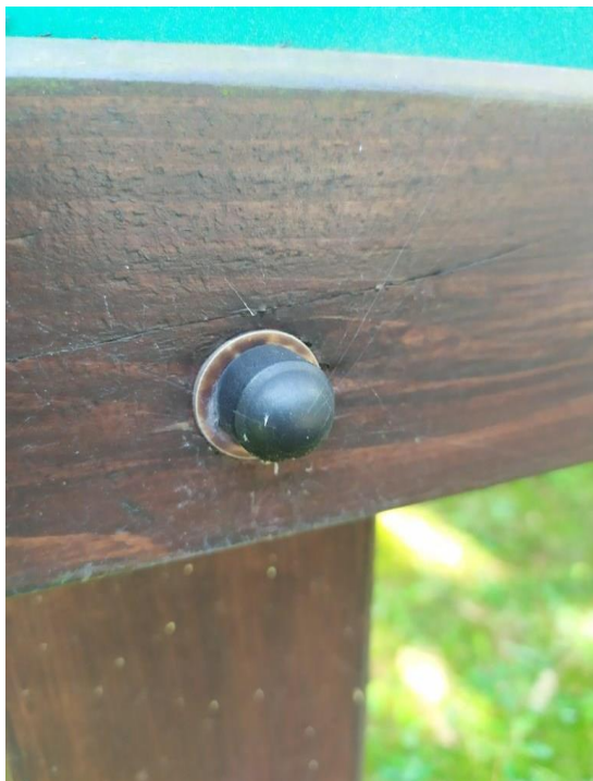
Śruby (4 szt.) przytwierdzające tablicę w ramie do nóg stelaża
