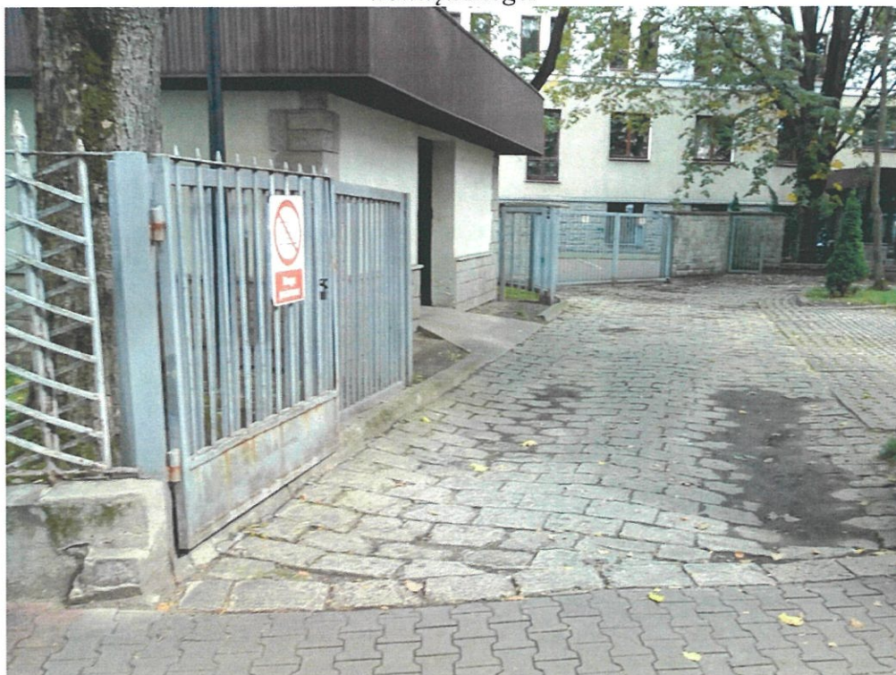
Fot. 8. Widok na przejazd od ul. Dunajeckiej.
