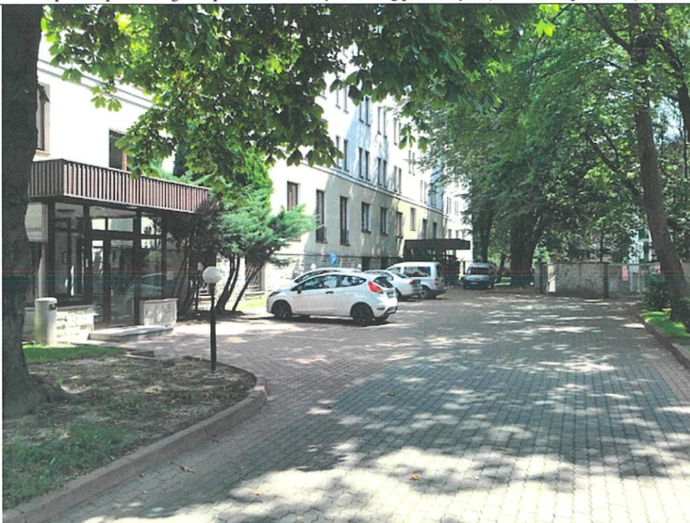
Fot. 7. Dostęp / dojazd do wejść/wyjść z klatek schodowych KL.1 i KL.2 – widok z placu wewnętrznego.
