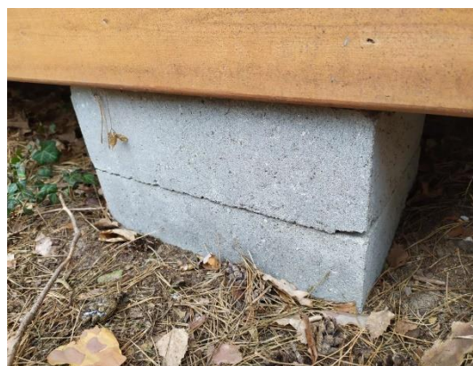
Domek posadowiony na bloczkach betonowych
