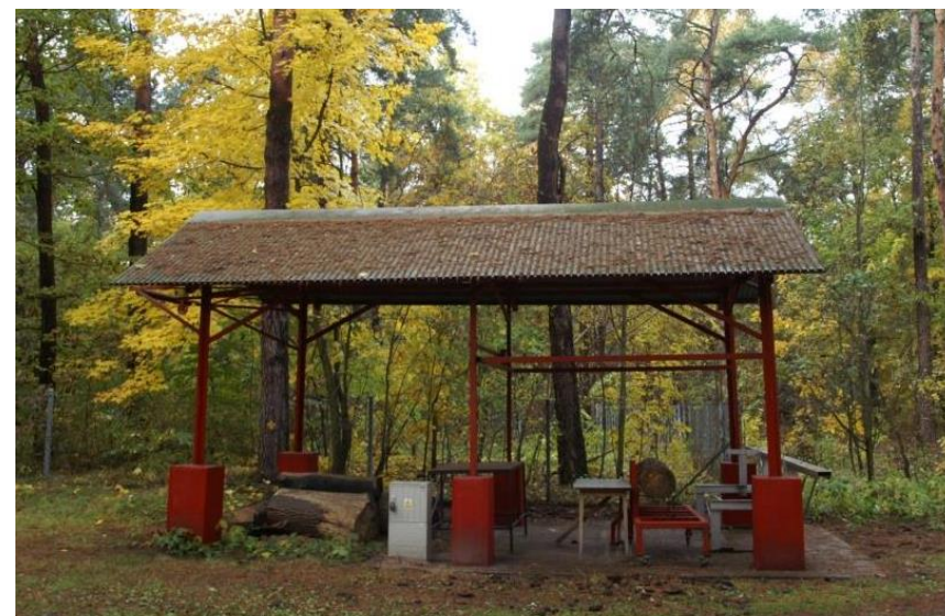
Stan nieaktualny - metalowe zadaszenie z urządzeniami pomiarowymi bez palisady drewnianej
