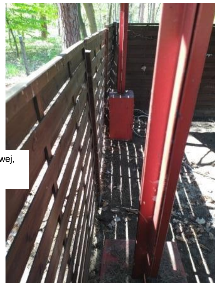
Możliwość odsunięcia projektowanej palisady od słupów nośnych zadaszenia metalowego
