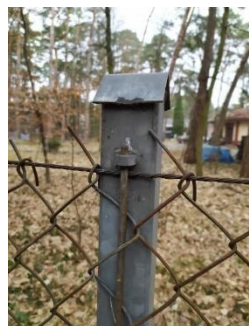
Istniejący słupek ogrodzenia z siatki
