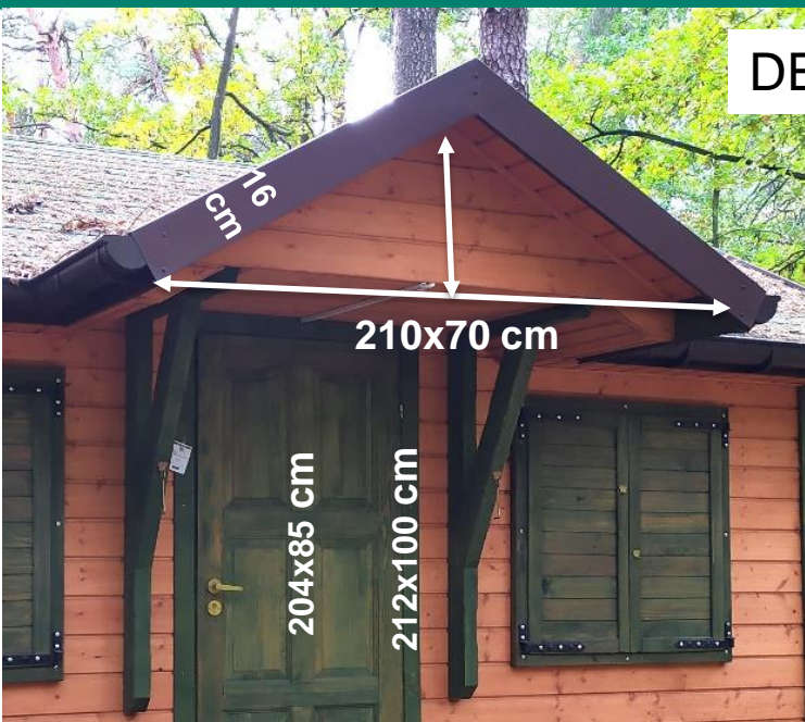
podpory dachu i okap z podbitką
