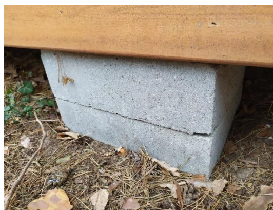
Domek posadowiony na bloczkach betonowych
