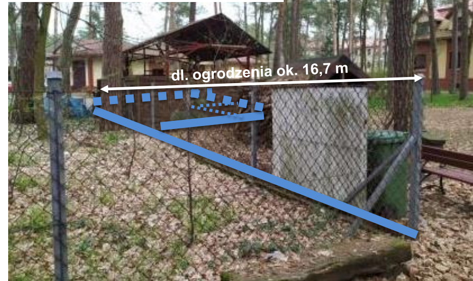
Teren od strony istniejącego ogrodzenia
