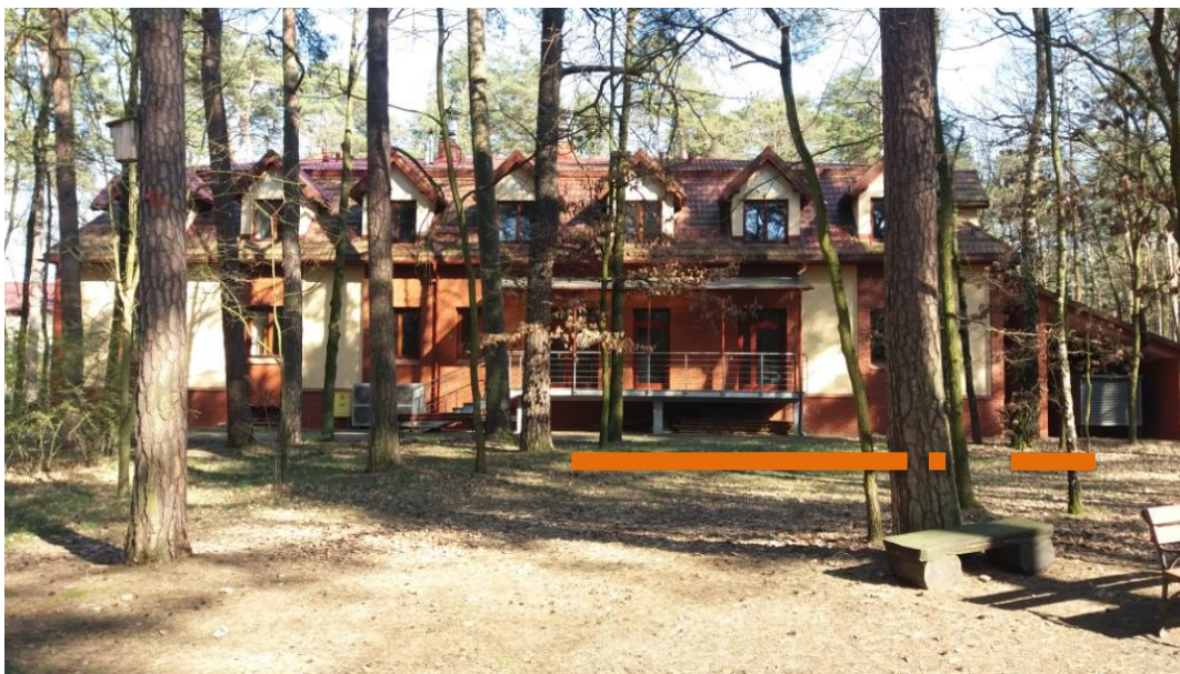
Miejsce lokalizacji panelu wystawienniczego nr 2
