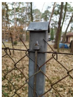
Istniejący słupek ogrodzenia z siatki
